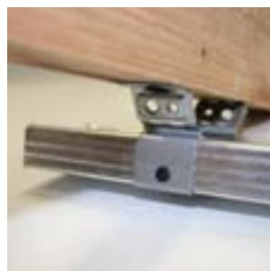
CD profil na CD klipu na krokvi
