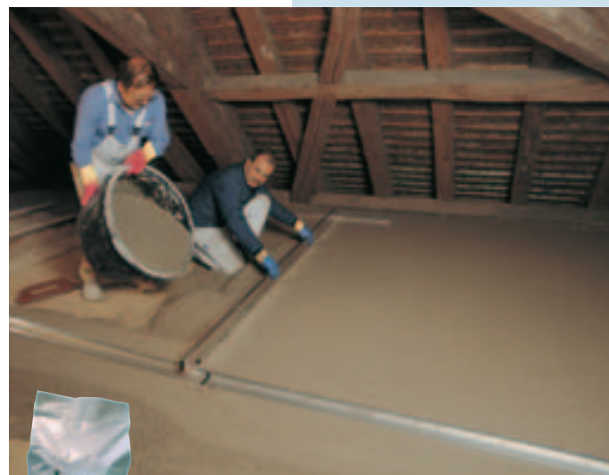
Knauf EPO-Leicht Pochozí vyrovnávací vrstva s minimální hmotností (200 kg/m³)
