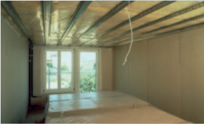
zateplené podkroví s parozábranou a namontovanými prvky Federschiene
