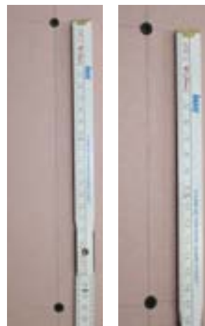
Osová vzdálenost šroubů - příčka 25 cm
