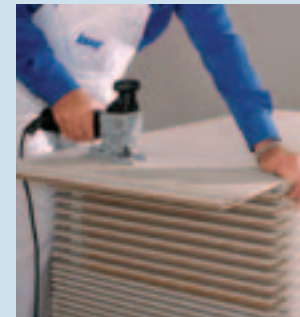
Desky Knauf Brio lze řezat okružní pilou nebo pilou děrovkou.
