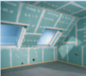
Zatmelené opláštění podkroví
