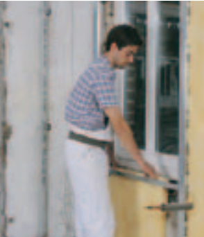
aplikace tepelné izolace
