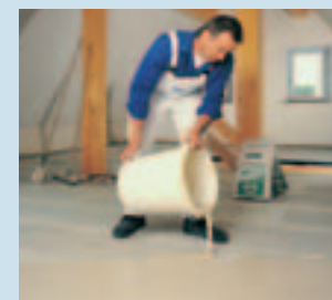
Ve stěrkové hmotě Knauf Nivellierspachtel 15 nevzniká pnutí, a tedy je ideální pro vystěrkování suchých podlah.
