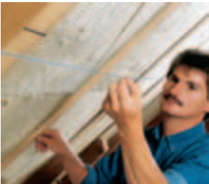
Montáž parozábrany a dřevěných latí
