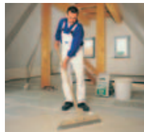
Pro snazší roztírání stěrky lze použít širokou špachtli s násadou.
