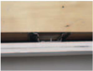
opláštění podkroví na prvku Federschiene
