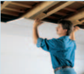
Opláštění vodorovné části podkroví
