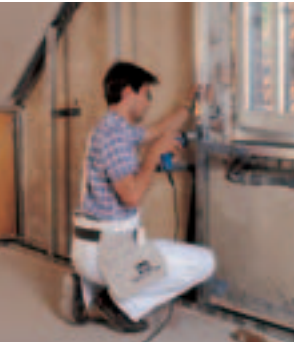
montáž podkonstrukce
