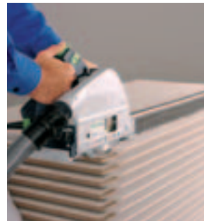
Na hraně pokládané u stěny odřízněte drážku.
