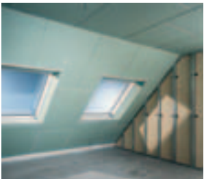
Dokončené opláštění - příprava ke tmelení
