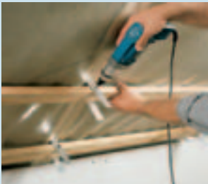
Upevnění montážních latí na konstrukci krovu
