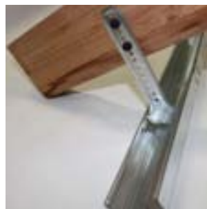
CD profil na krokrovém závěsu na krokvi
