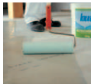
Povrch penetrujte přípravkem Knauf Estrichgrund (zředěným vodou v poměru 1:1).
