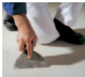
Stykové spáry desek vyplňte tmelem Uniflott
