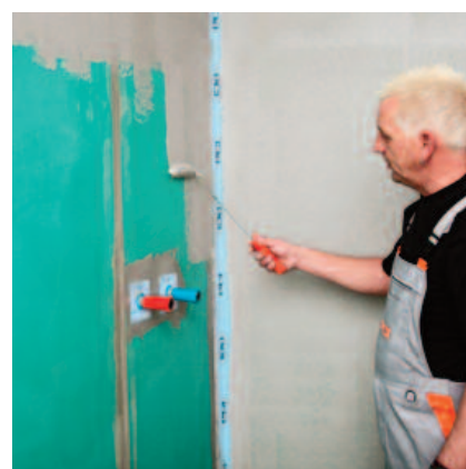
Potom nasleduje celoplošná hydroizolácia.
