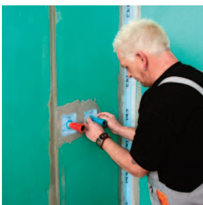
... podobne tesniace manžety opatrne prevliecť cez stavebnú zátku na rúrku a usadiť do čerstvej hydroizolácie.
