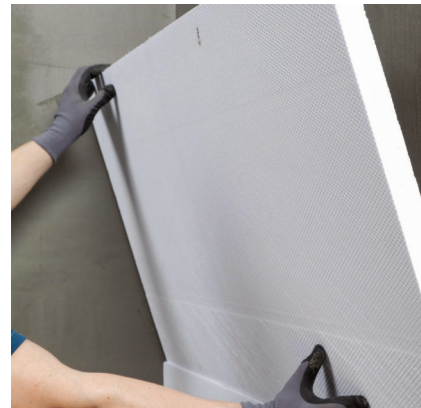
S PCI Barraseal Turbo sa môžu na vytvrdnutý podklad lepiť drenážne a izolačné dosky.
