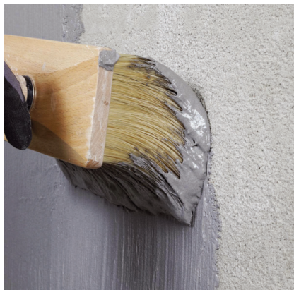
Nanesenie kontaktnej vrstvy štetkou alebo štetcom.
