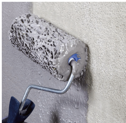
Nanesenie kontaktnej vrstvy valčekom.
