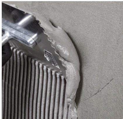
PCI Barraseal Turbo sa musí nanášať minimálne v dvoch vrstvách. Kvôli kontrole hrúbky vrstvy sa materiál môže naniesť ozubeným hladidlom a potom vyhladiť.
