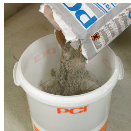
Pridať práškovú zložku PCI Seccoral® 2K Rapid.
