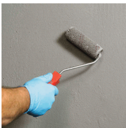
Prvý náter naniesť syto a celoplošne štetcom alebo valčekom.
