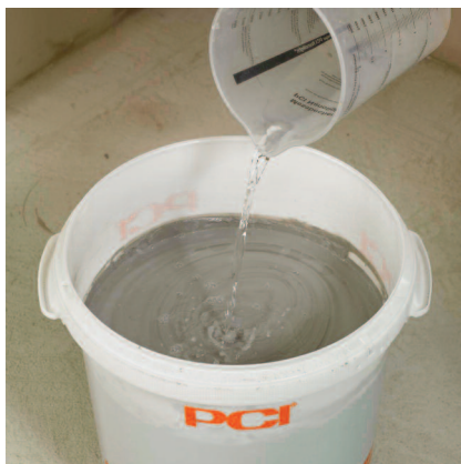
Pri aplikácii štetcom (1b) pridať zodpovedajúce množstvo vody.
