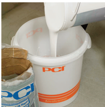
Tekutú zložku PCI Seccoral® 2K Rapid naliať do čistej nádoby.
