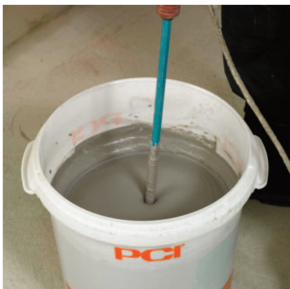
PCI Seccoral® 2K Rapid namiešať pri aplikácii hladidlom (1a) na homogénnu zmes.
